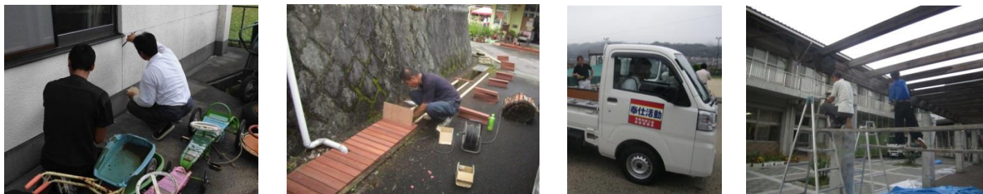
《教育施設 修繕奉仕活動の様子》
